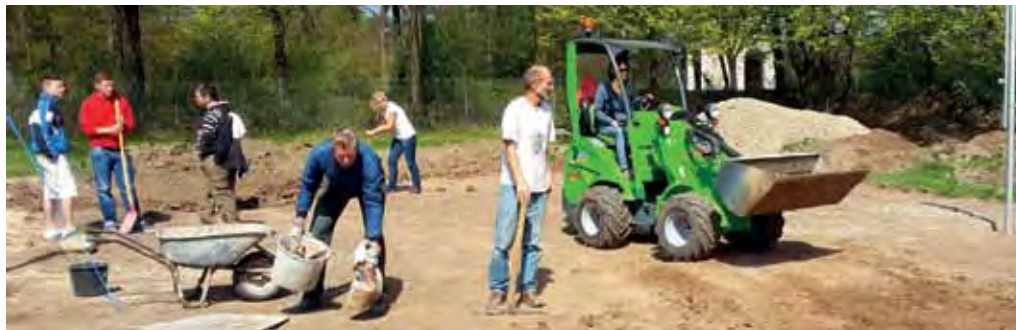
Baggerfahren statt Bälle baggern – Volleyballsparte beim Bau des 4ten Beachfeldes
