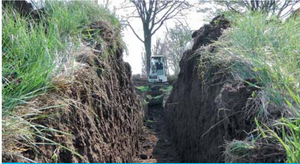
Erdarbeiten mit schwerem Gerät
