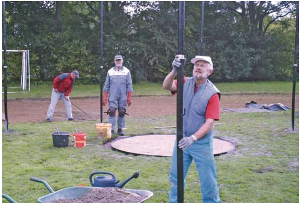
Bau der neuen Leichtathletikanlage in nur 11 Monaten
